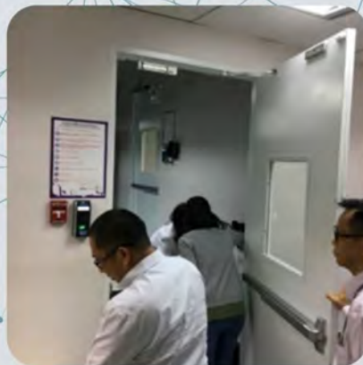
การ Access data center
