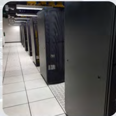
ระบบพื้น 2 ชั้น ยกพื้นสูงขึ้นเพื่องานระบบป้องกันการรั่ว ของน้ำที่อาจก่อให้เกิดความเสียหายกับอุปกรณ์ คอมพิวเตอร์
